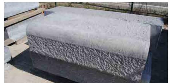
Tablette de bord de Meuse, les parties verticales et horizontales sont "sbattues" à la pointe, la partie arrondie étant bouchardée © SPW-SG/J. VANDENBROUCKE
