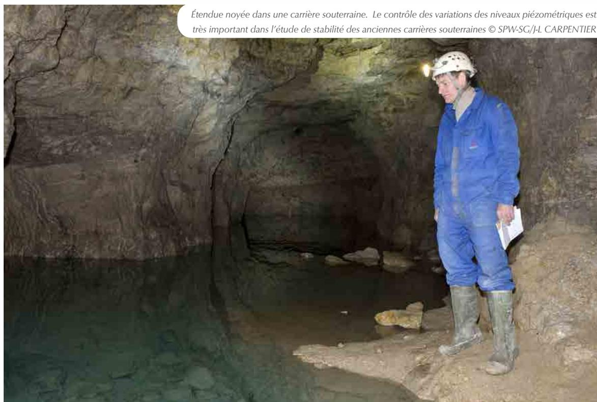
Étendue noyée dans une carrière souterraine. Le contrôle des variations des niveaux piézométriques est très important dans l'étude de stabilité des anciennes carrières souterraines © SPW-SC/J-L CARPENTIER
